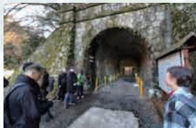
▲東海道線トンネル跡
