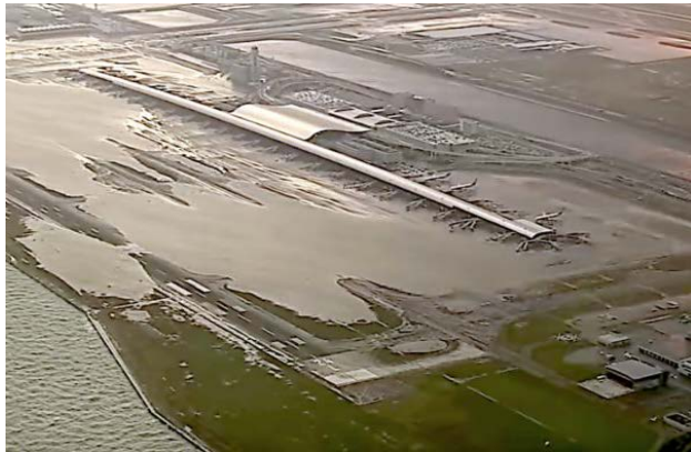
浸水する関西国際空港 (2018)
