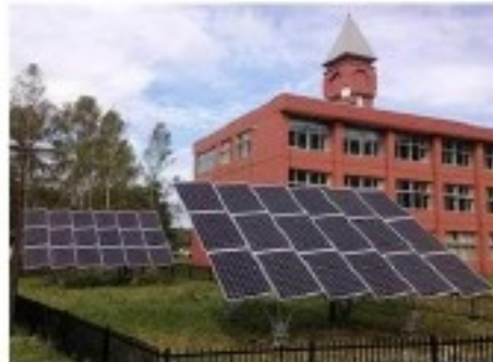
避難所に設置した太陽光発電
