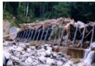
流木補足式治山ダムの設置
