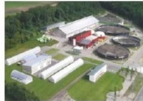
バイオガス発電・熱利用
